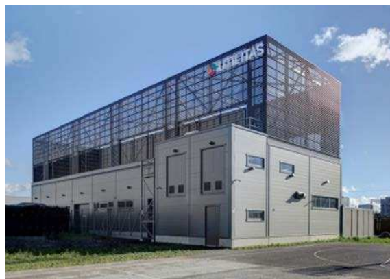
Utilitase uus kaugjahutusjaam
