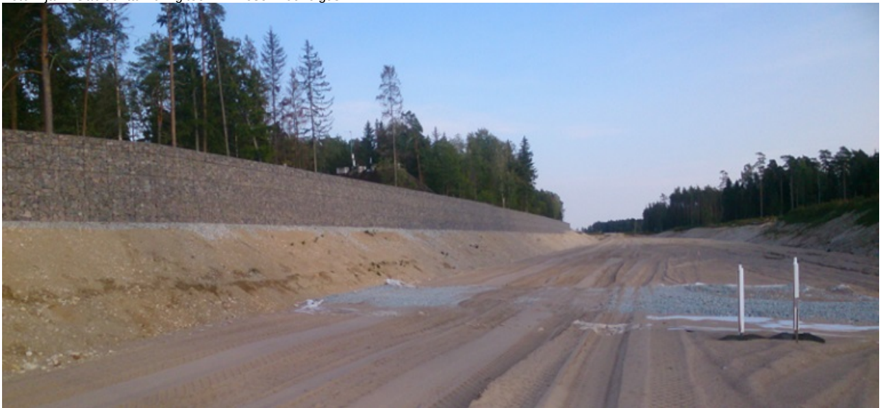
Foto 1 ja 2: Gabioontarind riigitee nr 2 Kose-Ardu lõigul
