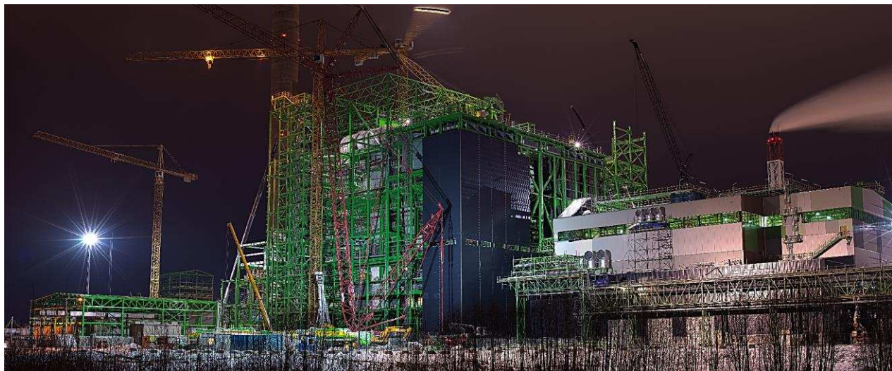
2014. AASTAL VALMIV TÖÖSOLEV SUUROBJEKT: IDA-VIRUMAAL AUVERES EESTI ELEKTRIAAMA TERRITOORIUMILE RAJATAVA PÕLEVKIVI JA BOKÜTUSE ETTEANDESÜSTEEMIDE ELEKTRISÜSTEEMIDE EHTUSTÖÖD KOOS VAJALIKE SEADMETEGA
