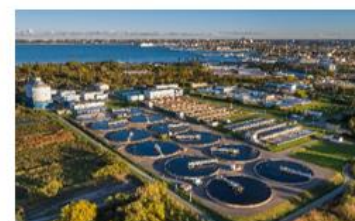
Paljassaare reoveepuhastusjaam, kompostimisväljakud ja heitveelabor
