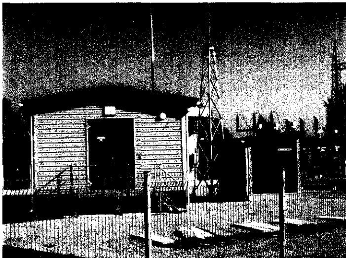
Pärnu Metsakombinaadi alajaama 110/35/10 KV jaotusseadme 10KV jaotlahoone. Projekteeris ja ehitas KEKi Ehitus.
