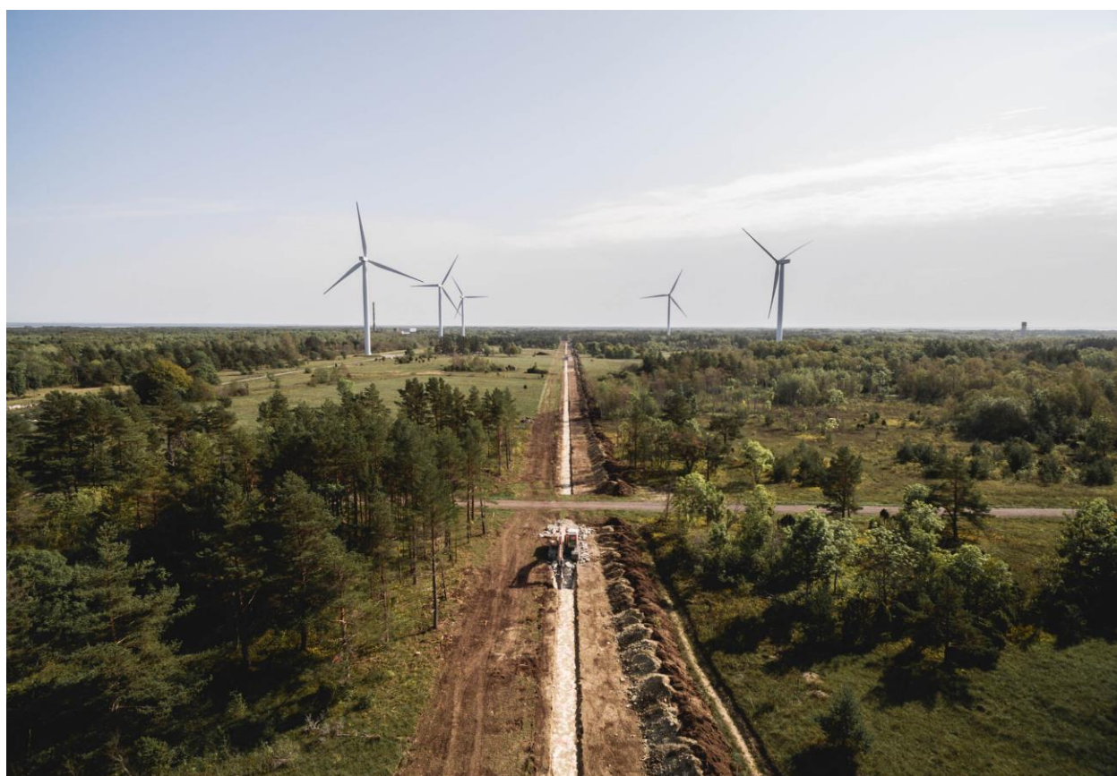
Kiili-Paldiski DN700 MOP54 gaasitoru pinnasetööd. Kaurits OÜ
